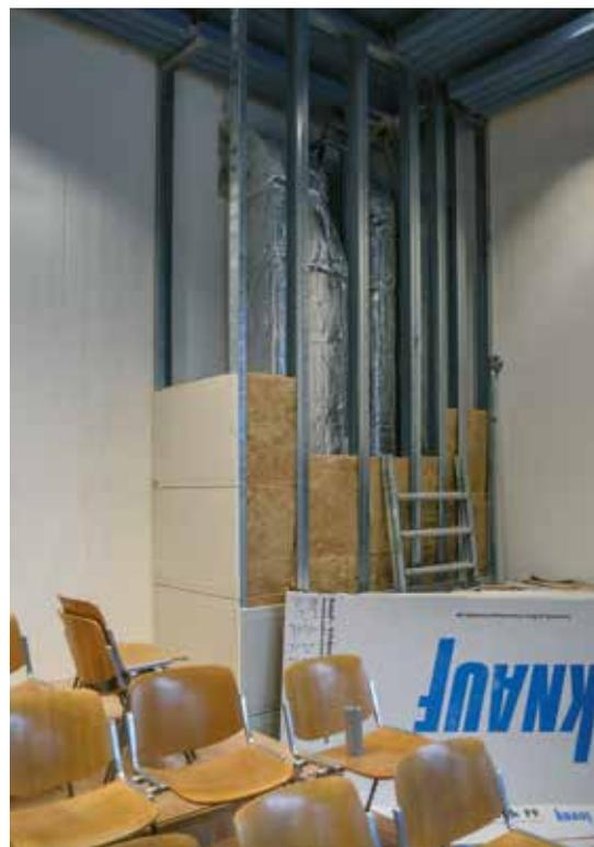
*Noch fehlen im kleinen Chorsaal Teile der Deckendämmung und die abgehängten Elemente. Maler und Fußbodenleger brauchen dann nur ein paar Tage, um den Raum betriebsbereit zu machen. An der Wand die schon eingehausten Lüftungskanäle.*
